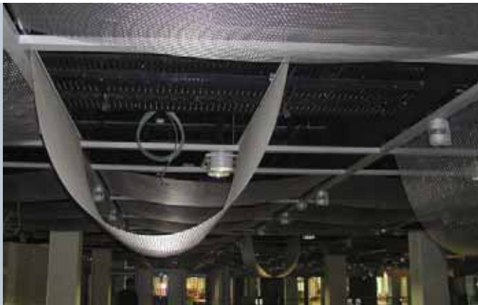
Gewebe mit Schlitzprofil-Einfassung
