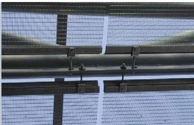
Gewebe mit Spannkanten und Gabelschrauben
