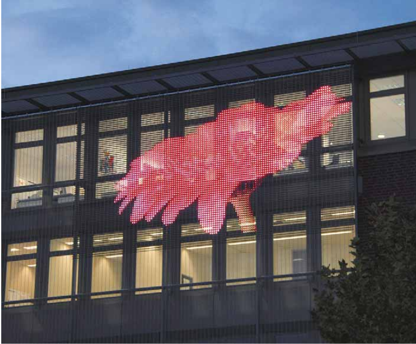
Projekt: Medienfassade Haver & Boecker, Oelde, Deutschland, Architekt: Architekturbüro Hilker
