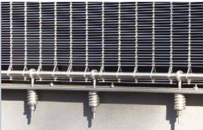
Untere Befestigung: Rundstab mit Augenschrauben und Druckfedern
