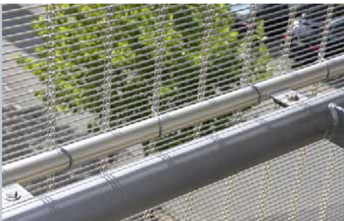
Zwischenbefestigung: Drahtsicherung
