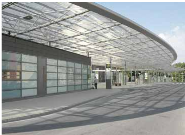
Projekt: Busbahnhof Herne, Herne, Deutschland Architekten: Heiderich-Hummert-Klein
