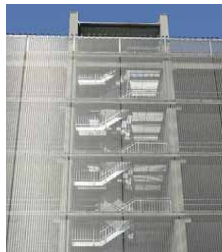
Projekt: Parkhaus 3–Airport Nürnberg, Nürnberg, Deutschland, Architekten: Kappler Architekten
